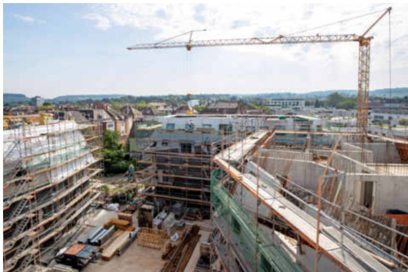
Das Bauprojekt Polygon mit fünf Gebäuden an der Heilbronner Happelstraße ist im Rohbau fertig. Im dritten Quartal 2024 soll Einweihung sein.
