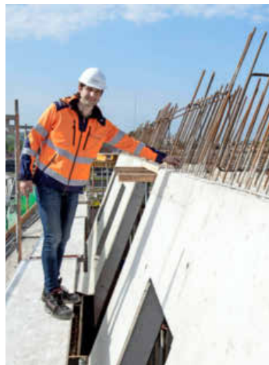
Geschäftsführer Fabian Caca ist mit dem Bau fortgang zufrieden.
